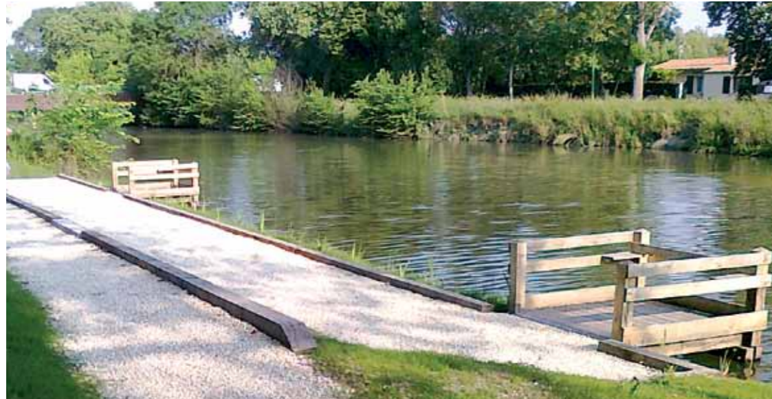
Berge aménagée pour les personnes en situation de handicap.
