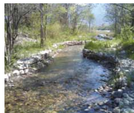
Chantier symbolique, la réhabilitation de l'adou de Saint-Thomas aura duré trois semaines pour un résultat dépassant aujourd'hui les espérances...
