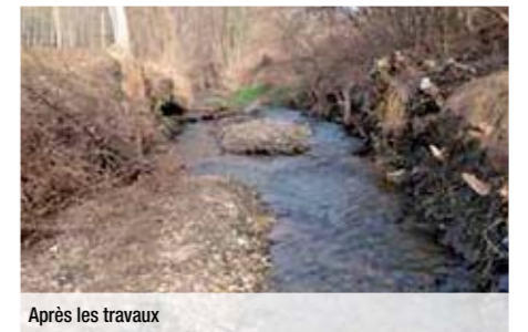
Après les travaux
