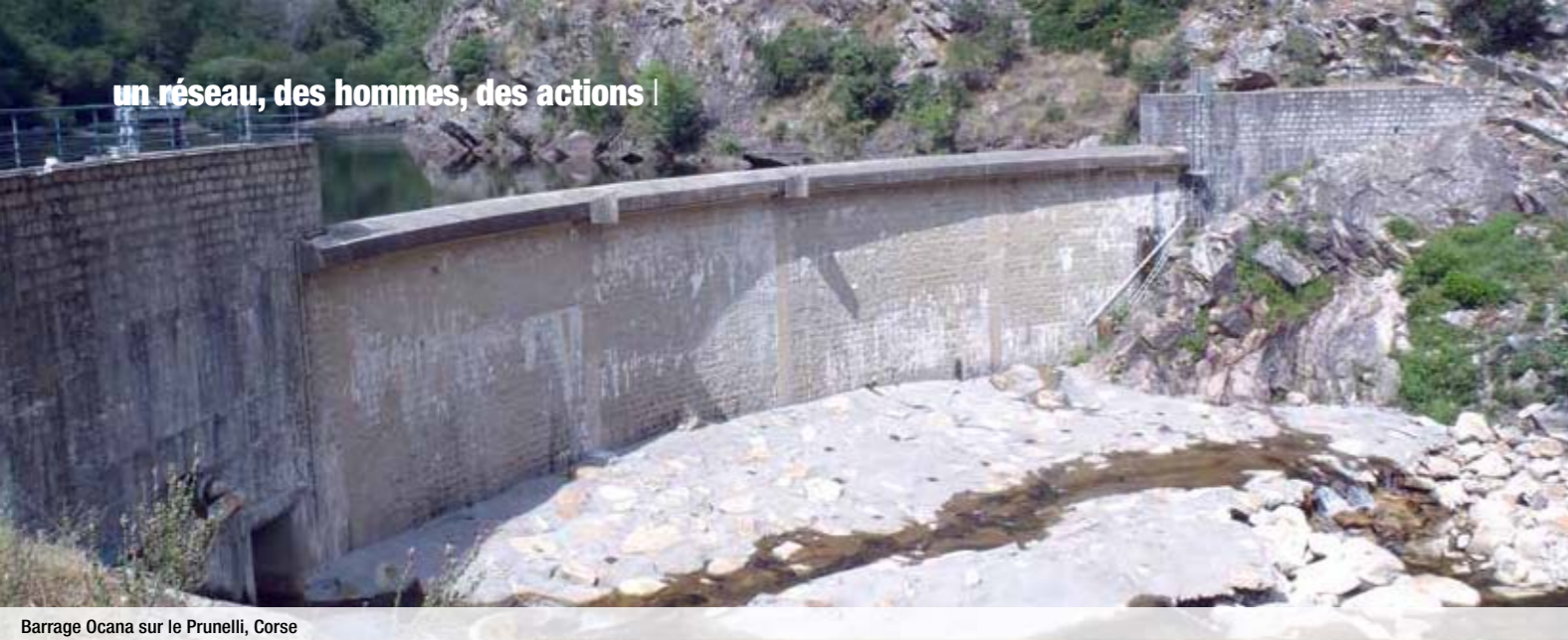
Barrage Ocana sur le Prunelli, Corse
