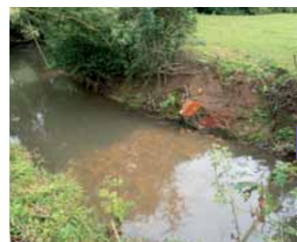
Réalisation d'un seuil de fond.
