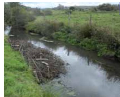
Réalisation d'un peigne.
